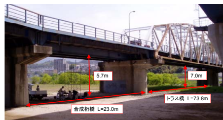
図7 合成桁橋およびトラス橋全景
